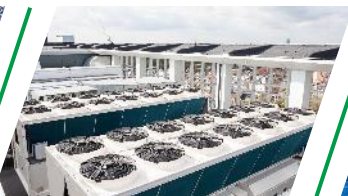
Filtragem de ar
